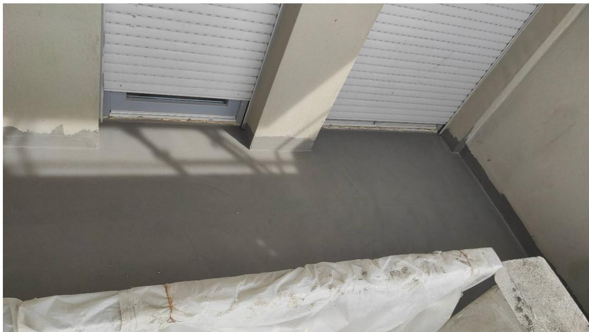
Parapetto in copertura: è stata stesa la tinteggiatura; in alcuni punti si sono rese visibili delle fessurazioni verticali nonostante la posa della garza. Nei punti ove presenti le fessurazioni verrà posato un giunto in lattoneria, dello stesso tipo di quello già presente nell'immobile.
